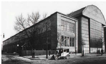
Peter Behrens, AEG-Turbinenfabrik, Berlin-Moabit, 1908-1909
